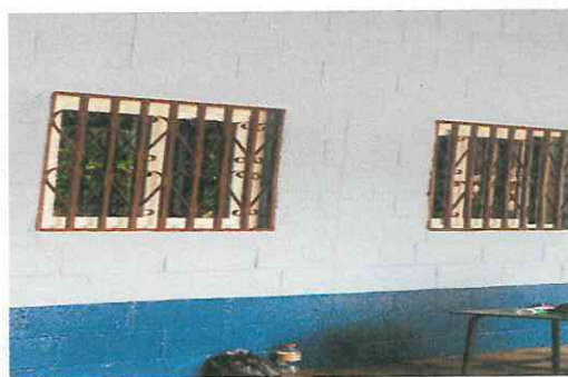
Foto 8: Mantenimiento de 15 balcones (Limpieza, reparación y pintura).
