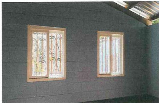
Foto 7: Sustrucción de ventanas por tipo pvc.
