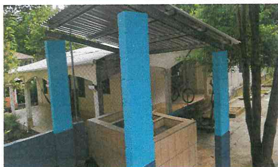
Foto 9: Cambio de techo y estructura metálica en pila.
