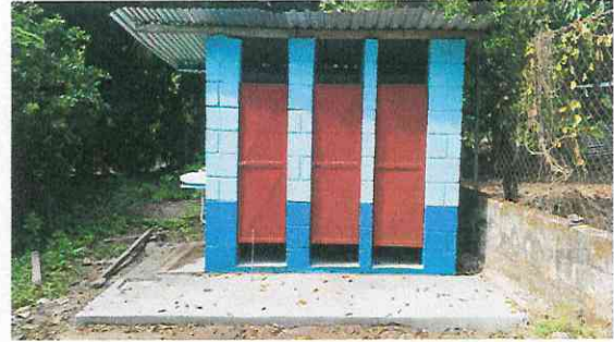
Foto 2: Mantenimiento de tres baños y dos lavamanos
