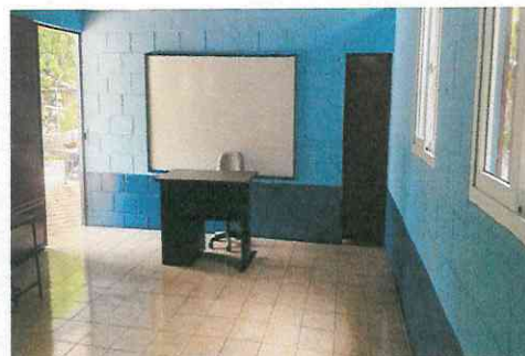
Foto 10: Colocación de piso cerámico en aula.
