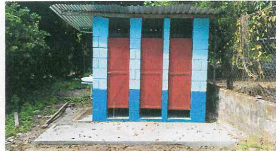
Foto 6: Reparación de banqueta de baños.
