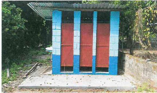
Foto 3: Cambio de tubería del tanque a baños .
